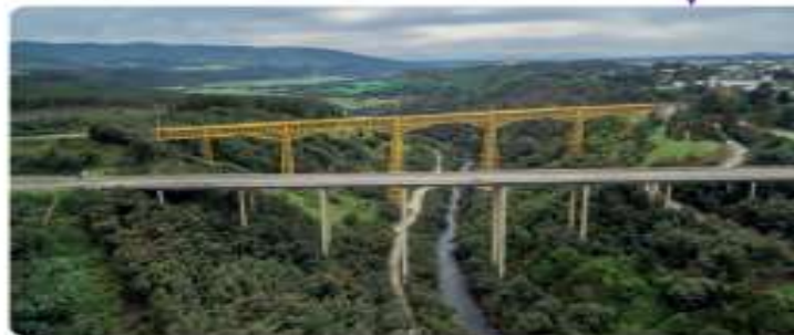
Viaducto del Malleco en la actualidad.
